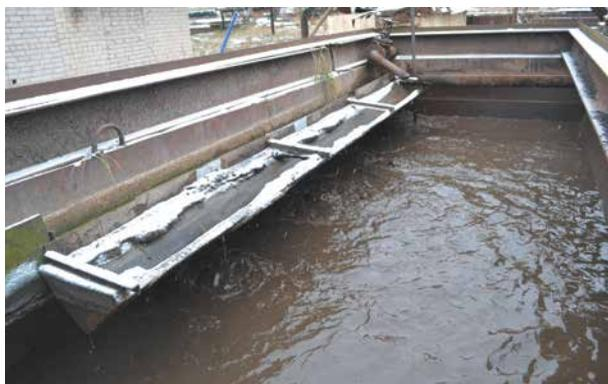
Рис. 4. Фото распределительного лотка для компактной установки
