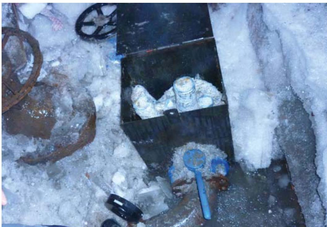
В камерах с трубопроводами выше уровня промерзания грунта регуляторы давления дополнительно утеплялись изолирующим материалом — мешками с опилками (рис. 8).
