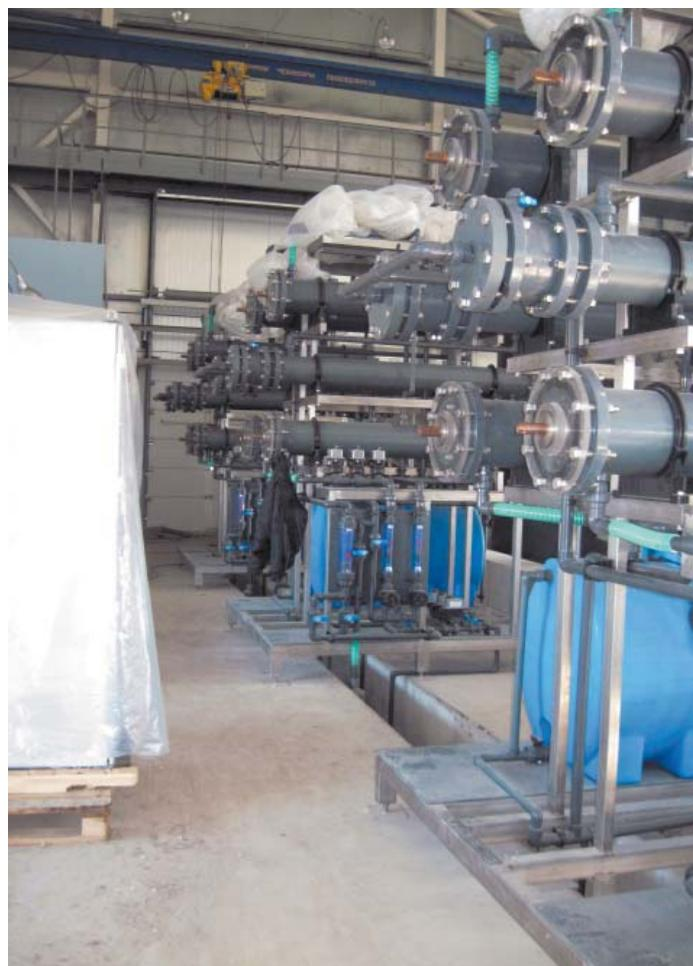
Рис. 9. Три электролизных установки «Хлорэкс» по 500 кг/сут каждая на Левенцовских ВОС производительностью 150 тыс. м<sup>3</sup>/сут питьевой воды для нужд г. Ростова-на-Дону
